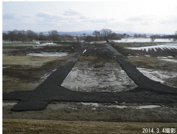
【完成】 水路が埋められ、両側に通路が造られました！
